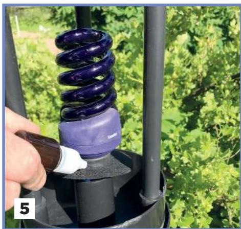
**5.** Ввернуть лампы УФО, проверить включением в розетку, отключить.
